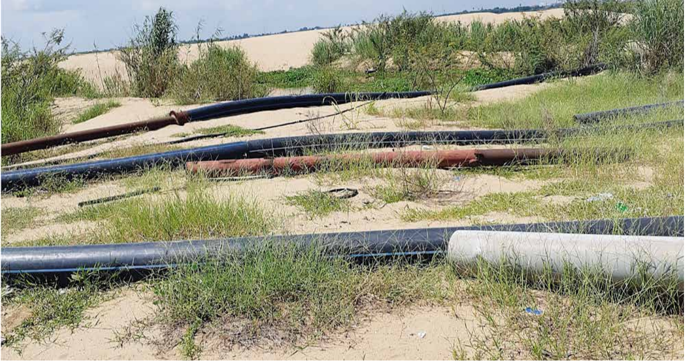
Über viele Kilometer werden Rohre verlegt, durch die kontinuierlich Sand in ein Feuchtgebiet geleitet wird (Foto: L. van Arragon, Oktober 2019).
