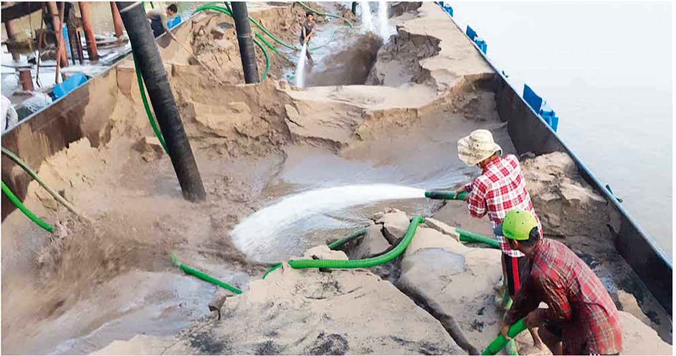
Arbeiter blasen Wasser auf den Sand, um ihn zu lösen, damit er durch große Rohre aus dem Kahn gepumpt werden kann. Bis zu zehn Arbeiter arbeiten eine Stunde lang an der Entleerung eines Bootes (Foto: L. van Arragon, Oktober 2019).
